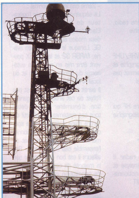
Pylône contre-mesures radar.
